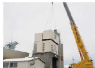
クレーン解体
