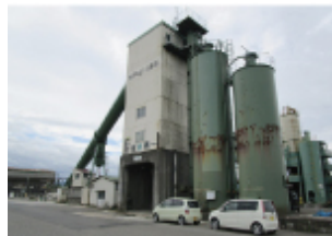
プラント解体前
