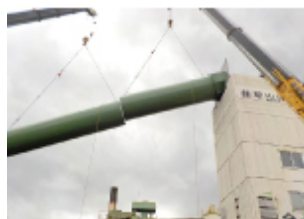
クレーン解体
