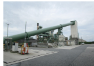
プラント解体前
